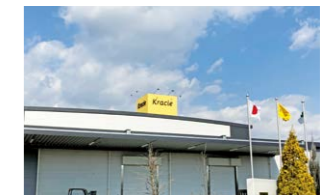
高槻工場 大阪府高槻市
